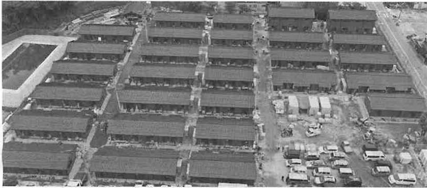
輪島市鳳至(ふげし)応急仮設住宅=堀俊孝氏提供
